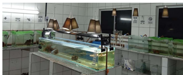
Figura 2. Sistema de Recirculação Aquícola para peixes ornamentais marinho.
